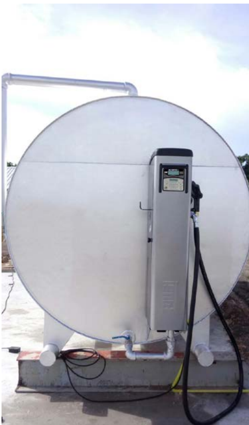
ELEKTRONISCHER ZÄHLER EINGEBAUT
